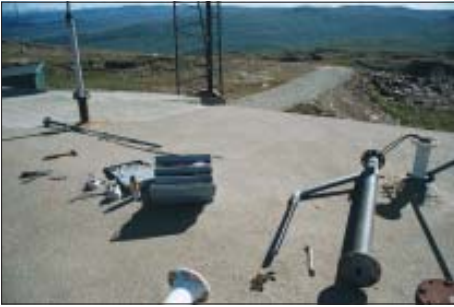
Selve Cathrain antenna etter at den er trekt ut av radomen. (til venstre for verktøykista). (foto: LA9QFA)
